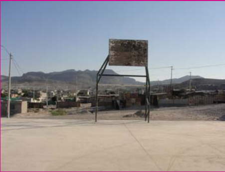
Fotografía 2: Estado actual del parque “Estrella del Poniente”.IMIP, 2012.
