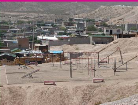
Fotografía 3: Estado actual del parque “Estrella del Poniente”.IMIP, 2012.
