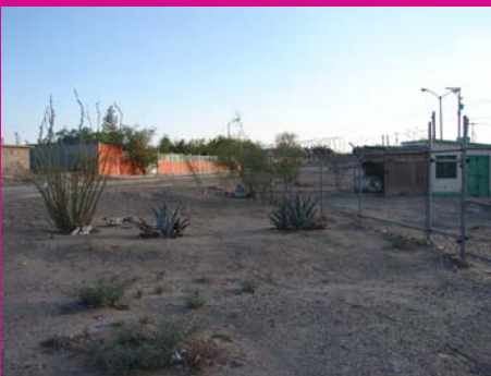
Fotografía 3: Pozo de la JMAS existente en el predio.
