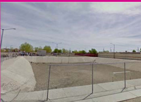
Fotografía 3: Dique existente “Parajes de Oriente” IMIP, 2012
