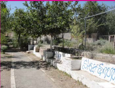
Fotografía 3: Vista de las bancas vandalizadas existentes en el parque.
