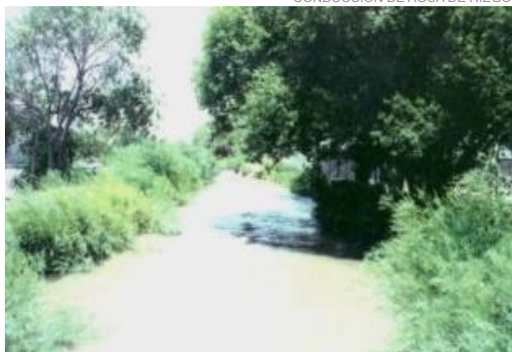
FIGURA 26. ACEQUIA PRINCIPAL PARA LA CONDUCCIÓN DE AGUA DE RIEGO
